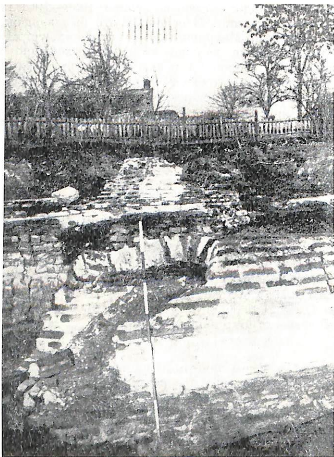
Рис. 2. Водосточный канал в общественных термах
